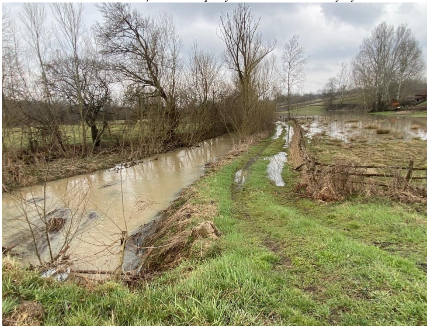
Оштећење цевастог пропуста на локалном путу
