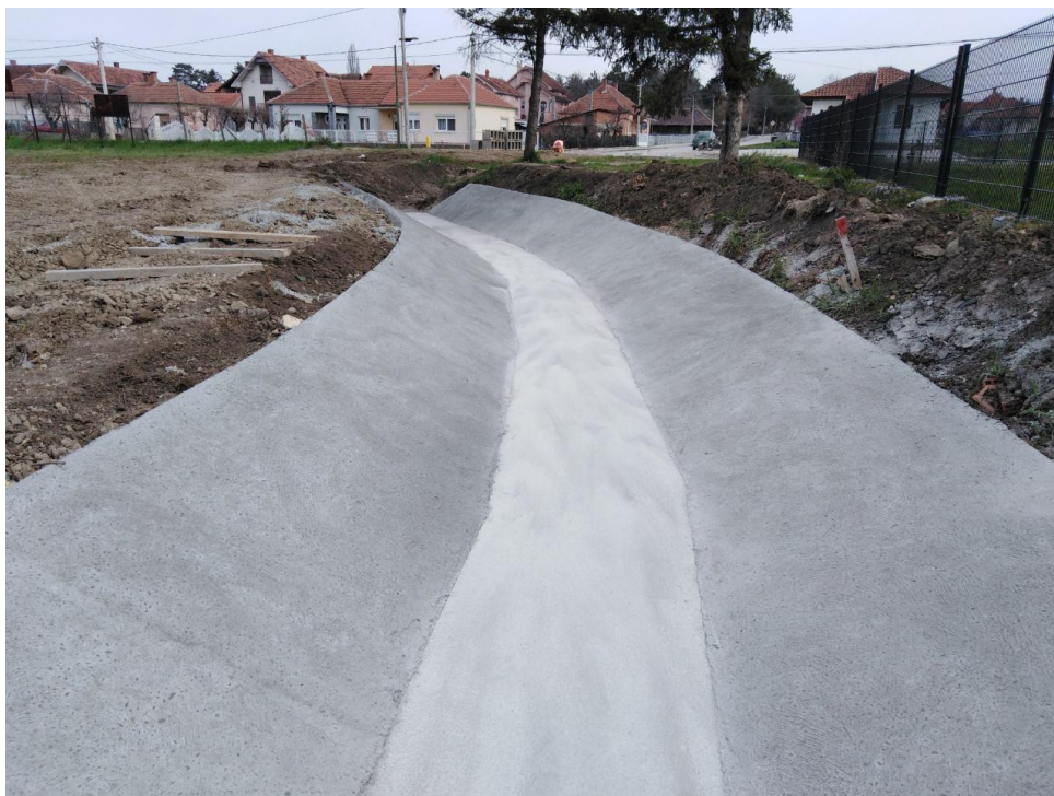
Безимени поток код фабрике меда – бетонско корито
