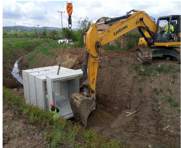
поток Крагујевчић – сандучасти пропуст код фабрике „Јура“
