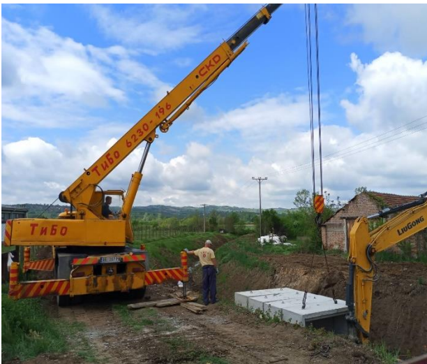
поток Крагујевчић – сандучасти пропуст код фабрике „Јура“
