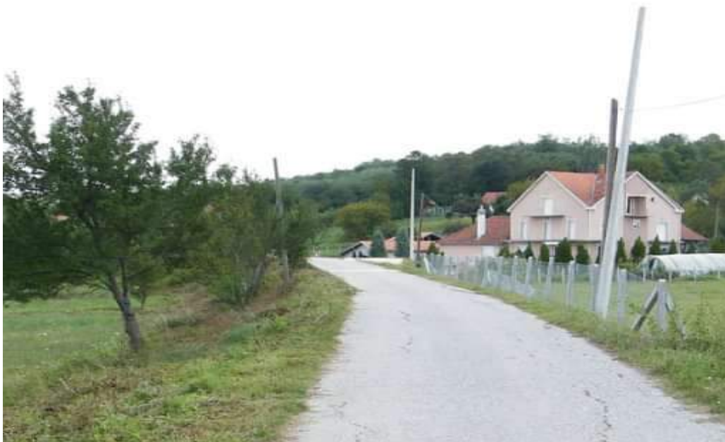
Slika2: Seoski put - postojeće
