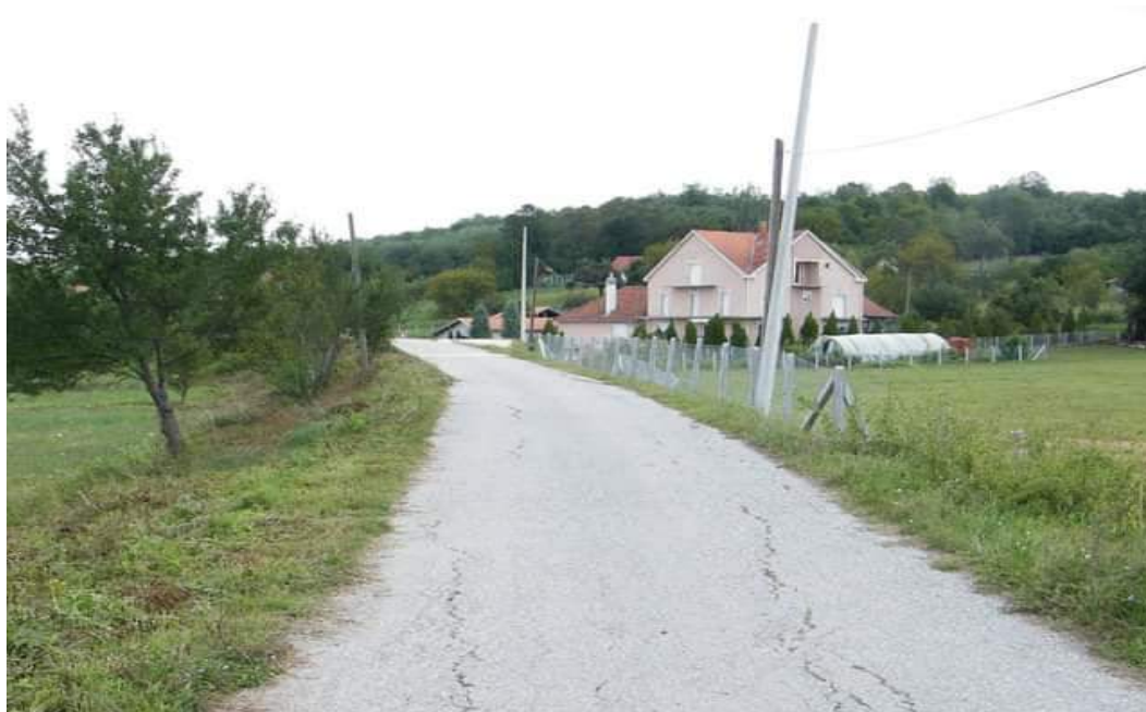
sl. 2 – postojeće stanje seoskog puta (ul. Tunelska)
