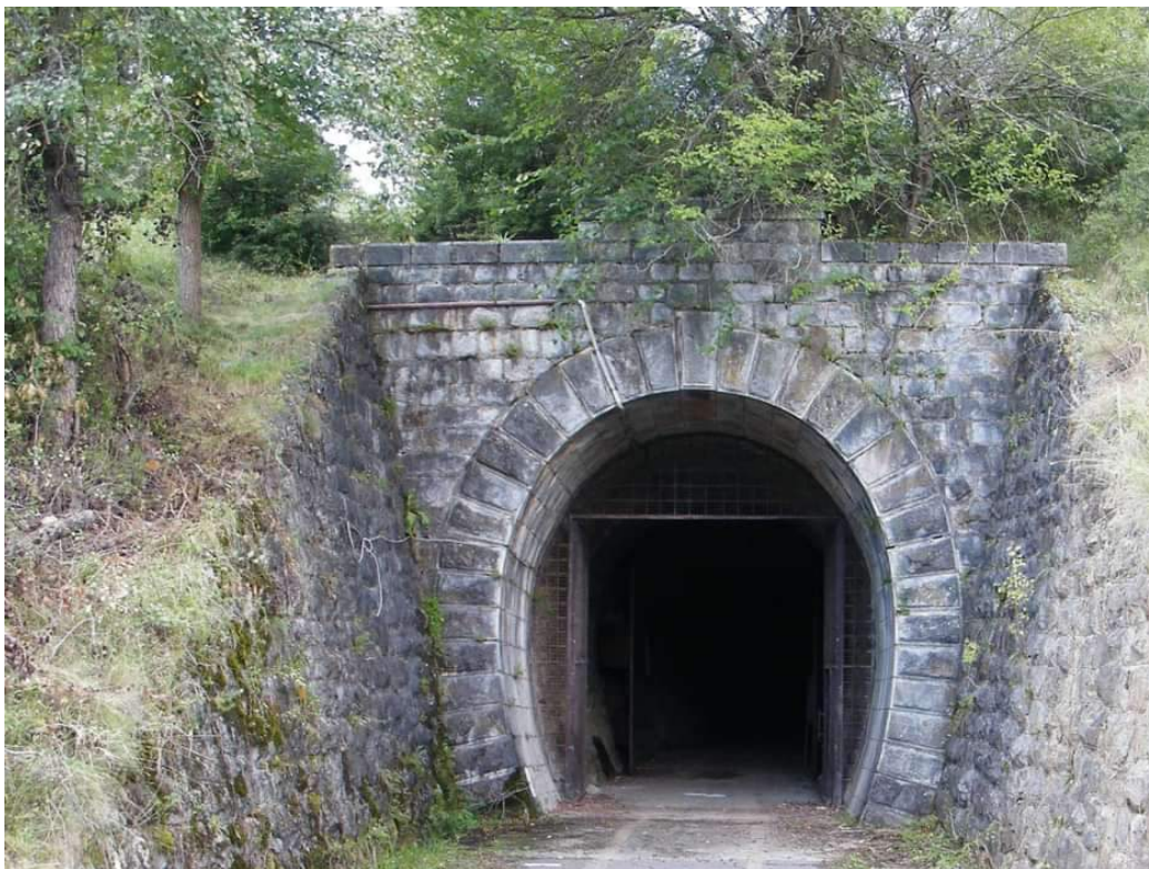
Slika1: Ulaz u tunel - postojeće
