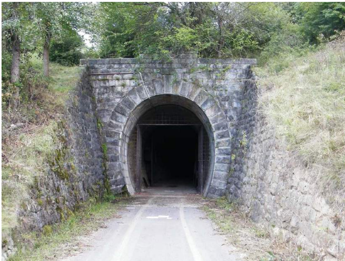
sl. 03 – ulaz u postojeći objekat tunela
