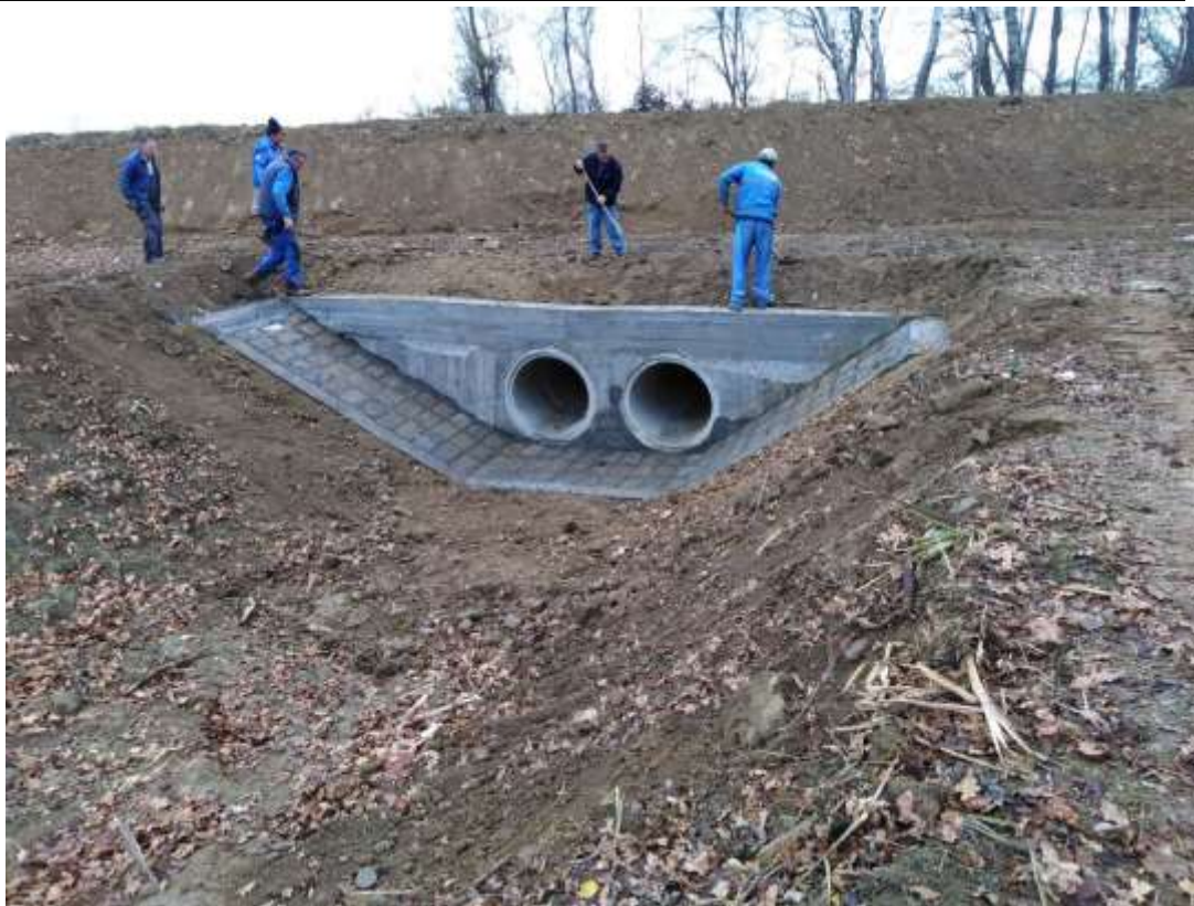
Пропуст на ушћу старог корита Јасенице у реку Јасеницу са колским прелазом
