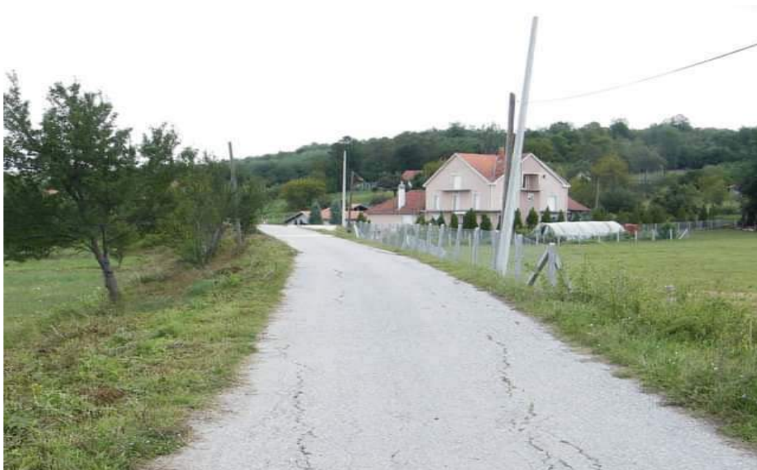
Slika3: Seoski put - postojeće
