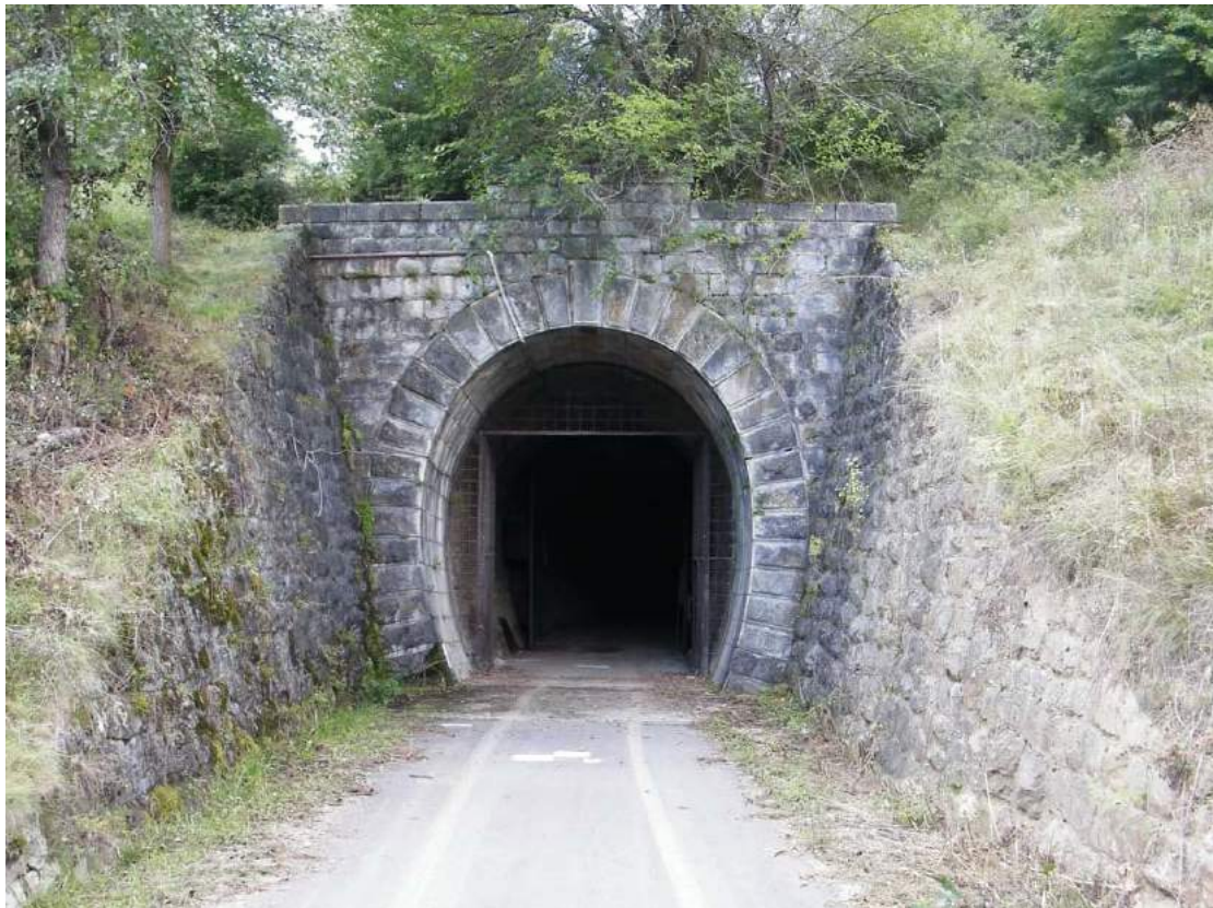
Slika2: Ulaz u tunel - postojeće
