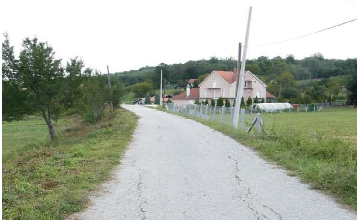
sl. 3 – postojeće stanje seoskog puta (ul. Tunelska)
