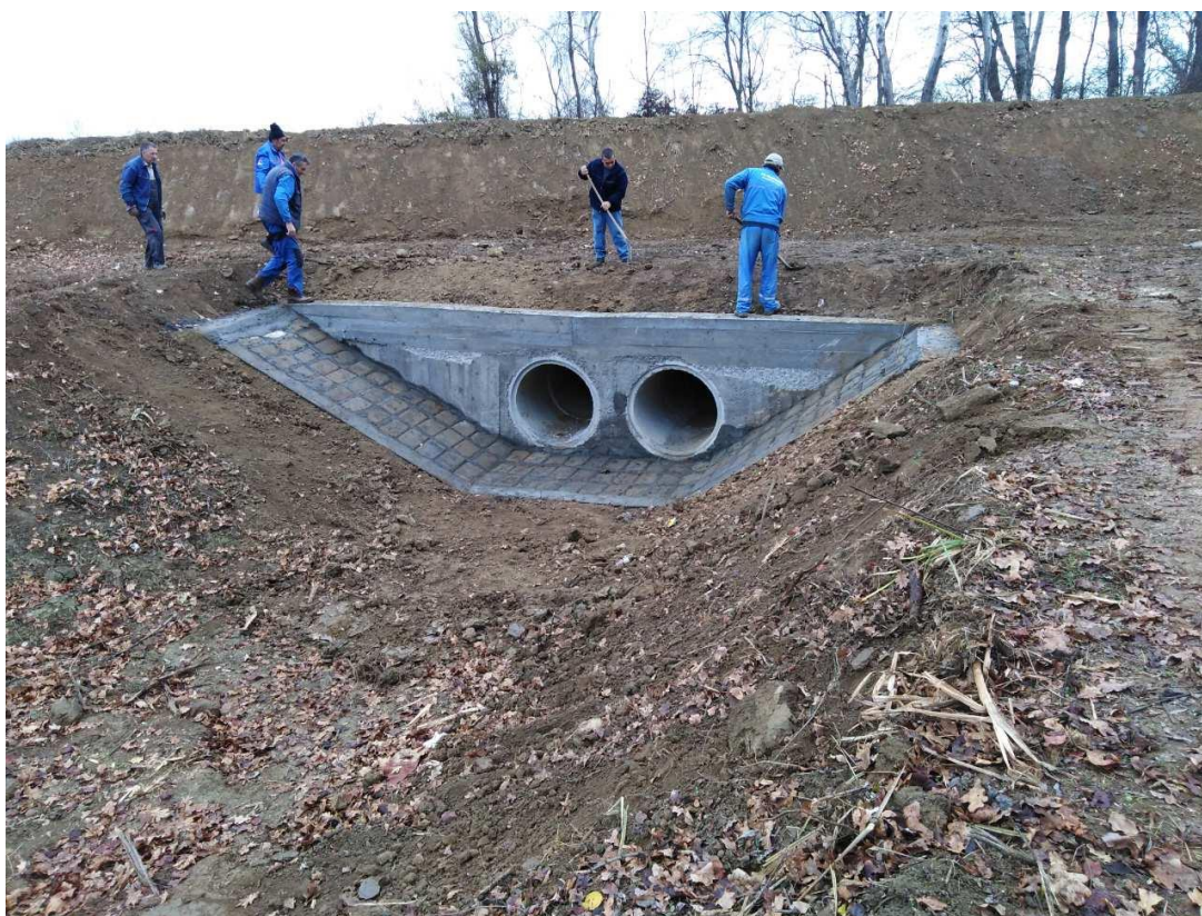
Пропуст на ушћу старог корита Јасенице у реку Јасеницу са колским прелазом
