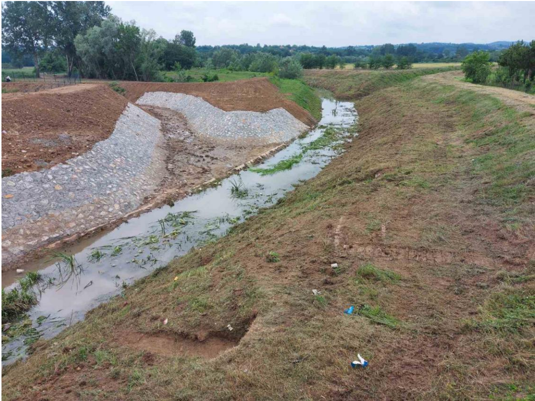
Мирашевачки поток - осигурање ушћа у реку Рачу са успорним насипима
