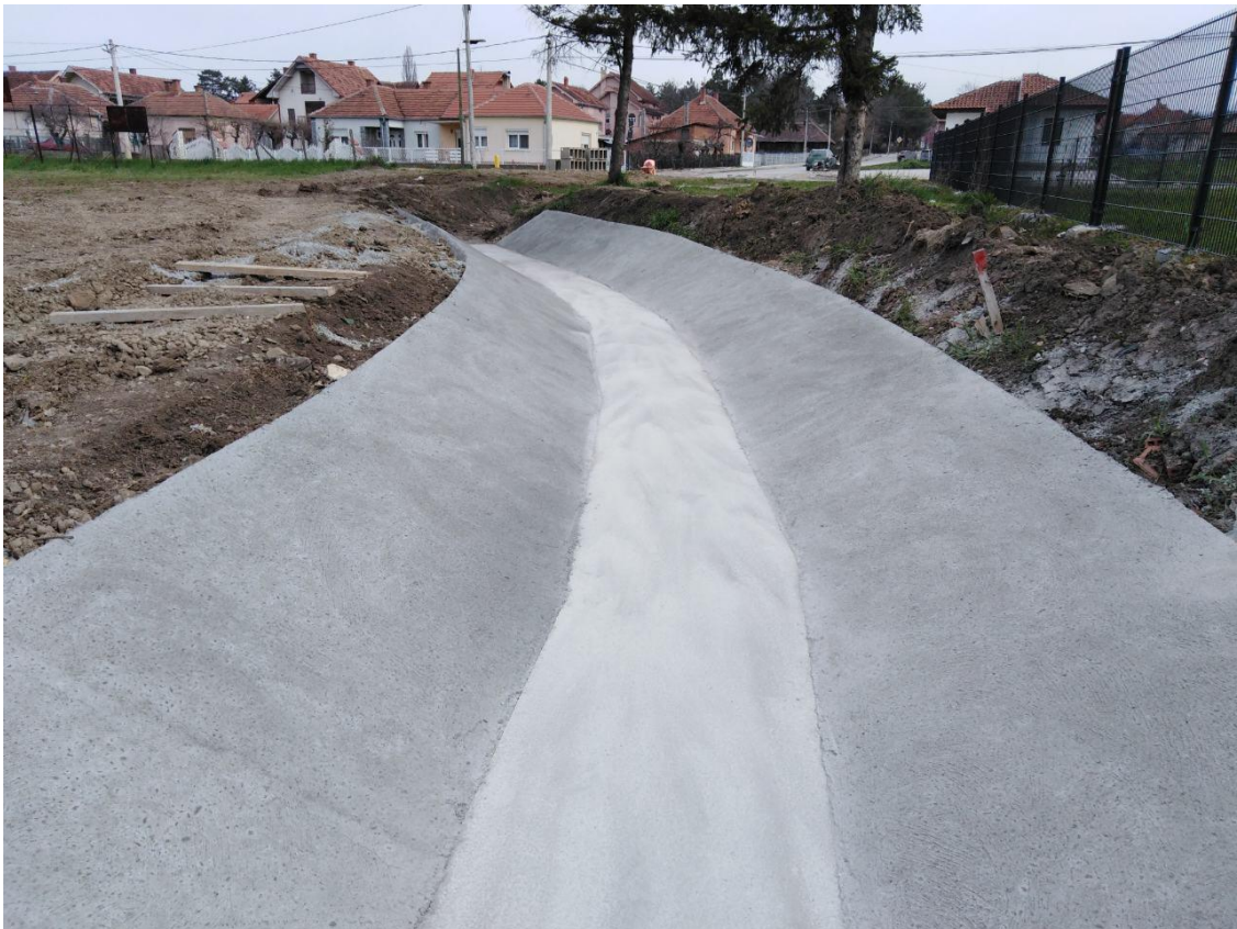
Безимени поток код фабрике меда – бетонско корито
