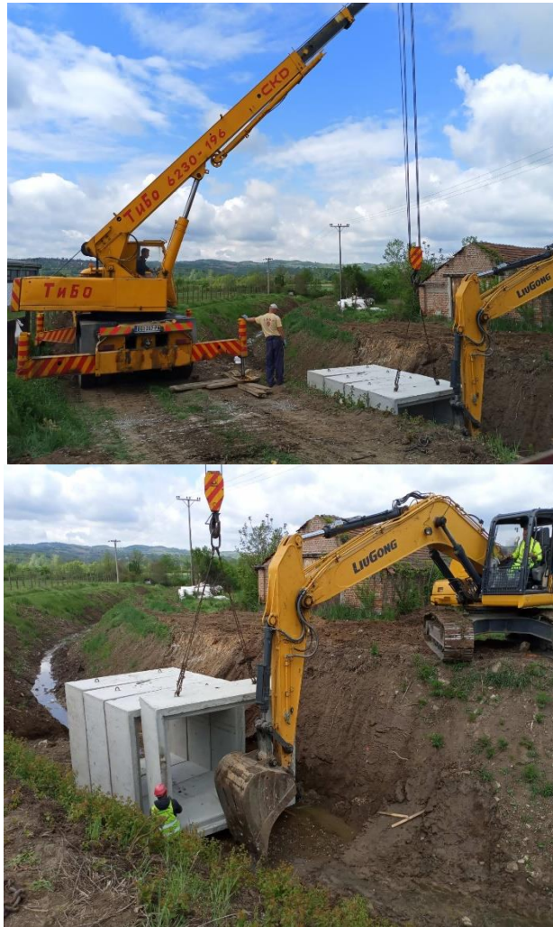
поток Крагујевчић – сандучасти пропуст код фабрике „Јура“
