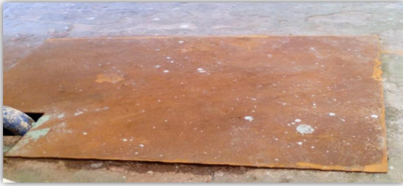
Слика бр. 23: Бетонски резервоар за воду у случају акцидента
