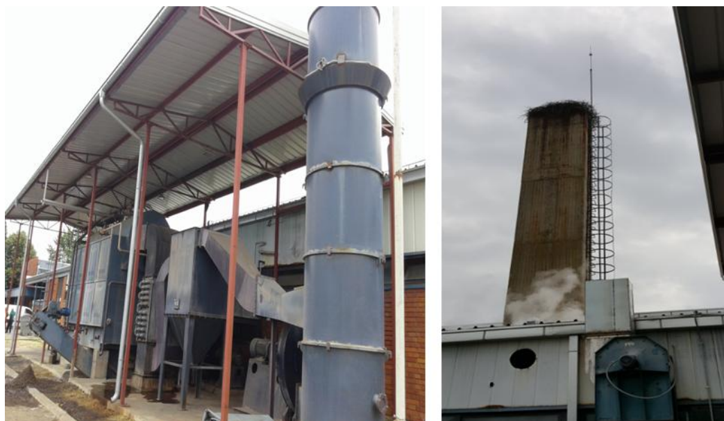
Слика бр.6: Приказ димњака и котловског постројења у оквиру комплекса предметног Пројекта
