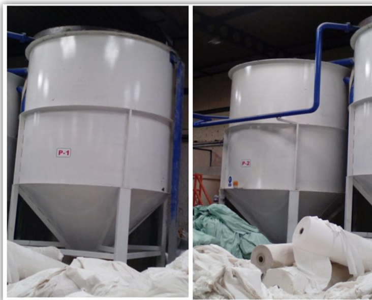
Слика бр. 22: Изглед конусних резервоара за воду
