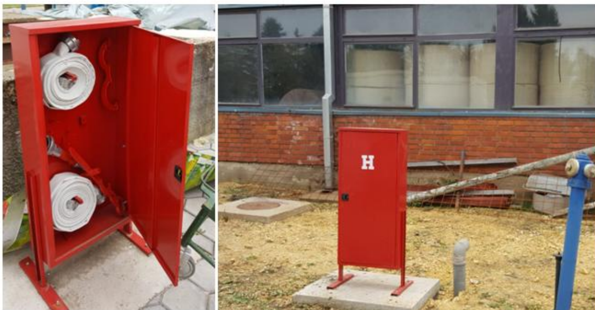
Слика бр.24: Приказ спољних хидрантских ормарића на Предметној локацији
