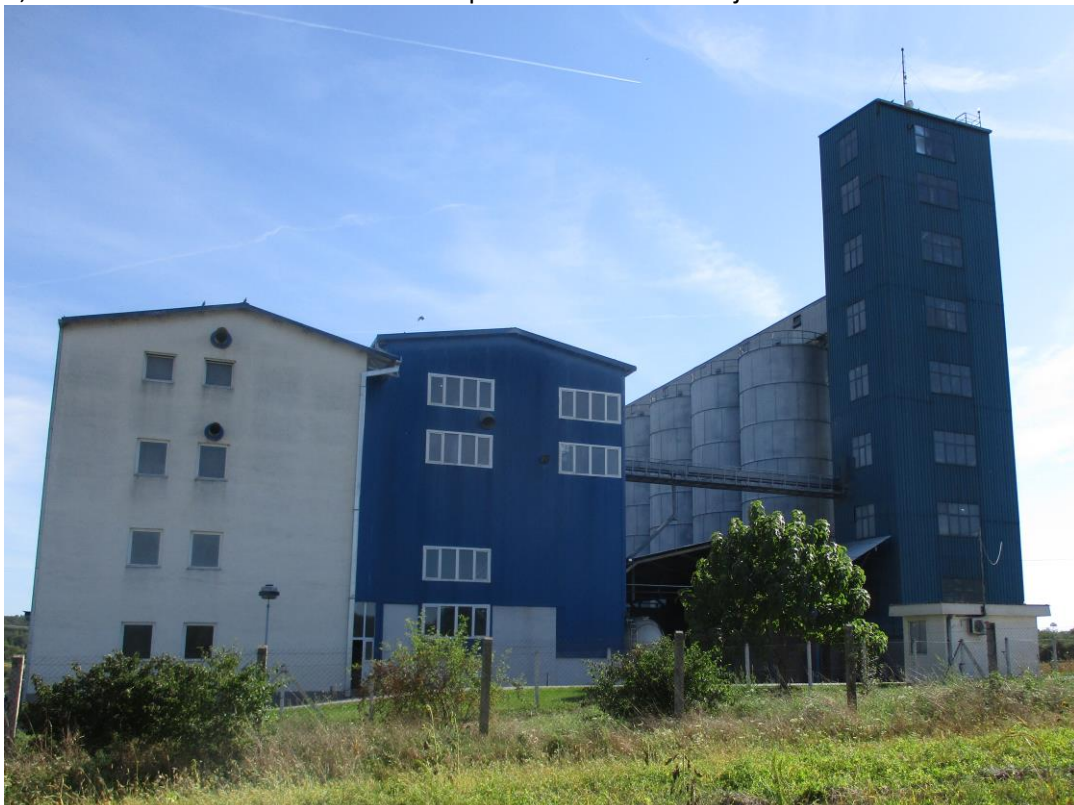
Slika 3.10 Izgled predmetne lokacije
